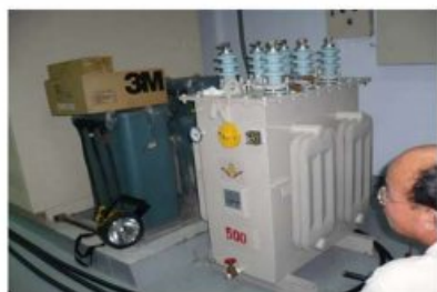
屏東縣盛*工業浸鋅加工廠 安裝高壓 SFH-400KVA 節電器 驗收節電率： 10.55%
