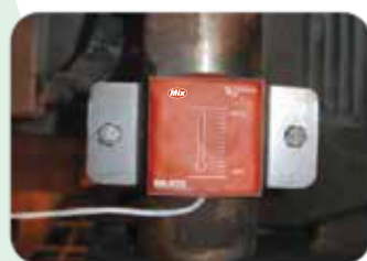
發電廠、汽電廠、熱回收管、吹灰器異常溫度偵測
