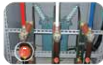
高壓保險絲過載異常溫度偵測
